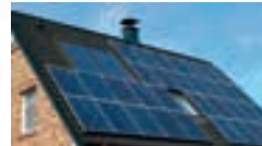
INSTALACIÓN DE PLACAS PARA AUTOCONSUMO
